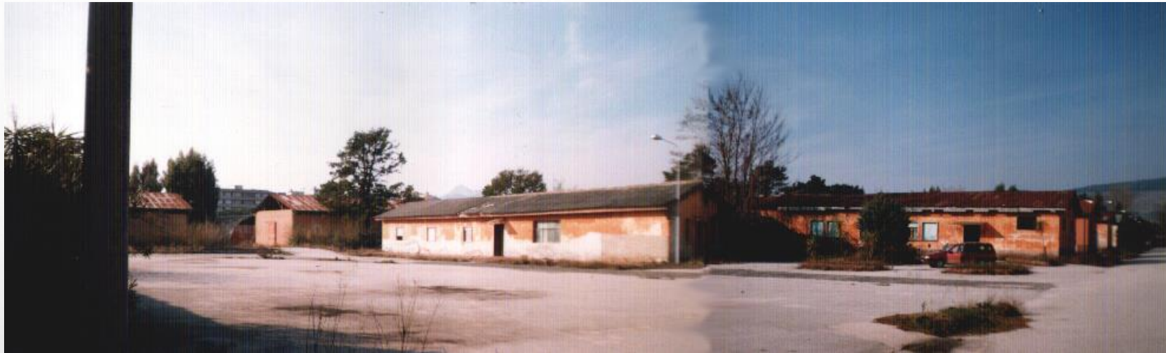
Magazzini (strutture orto botanico).
